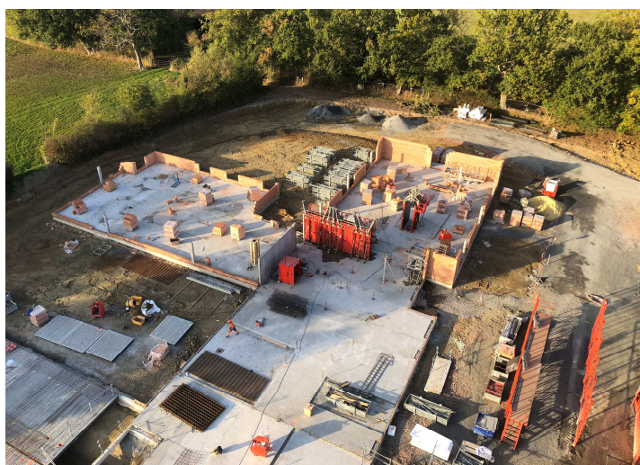
La fin des travaux du nouvel EHPAD est prévue en octobre 2019
